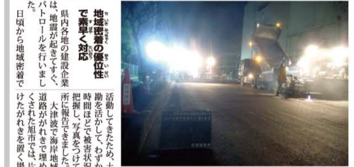
道路復旧作業は夜間も行われた（船橋市提供）
