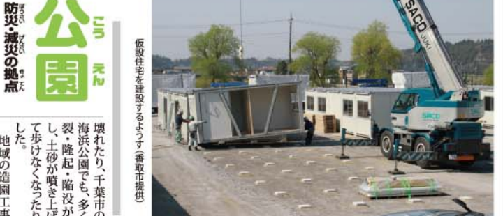
仮設住宅を建設する様子（千葉市提供）
